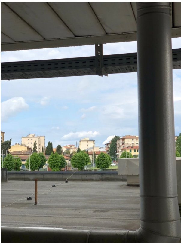
7. Porzione di copertura
