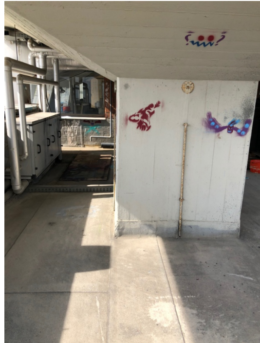
5. Particolare della guaina in corrispondenza del pilastro
