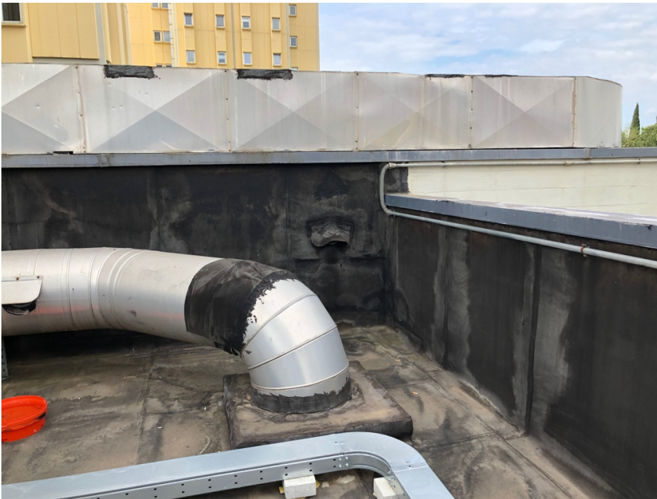
6. Particolare della guaina verticale
