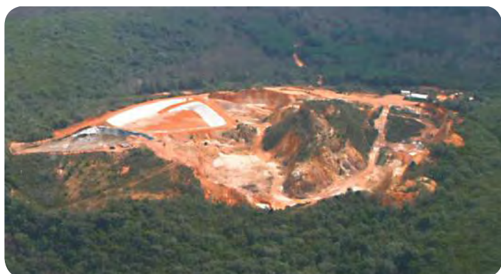
L'ex cava di Poggio Speranzona prima del ripristino
