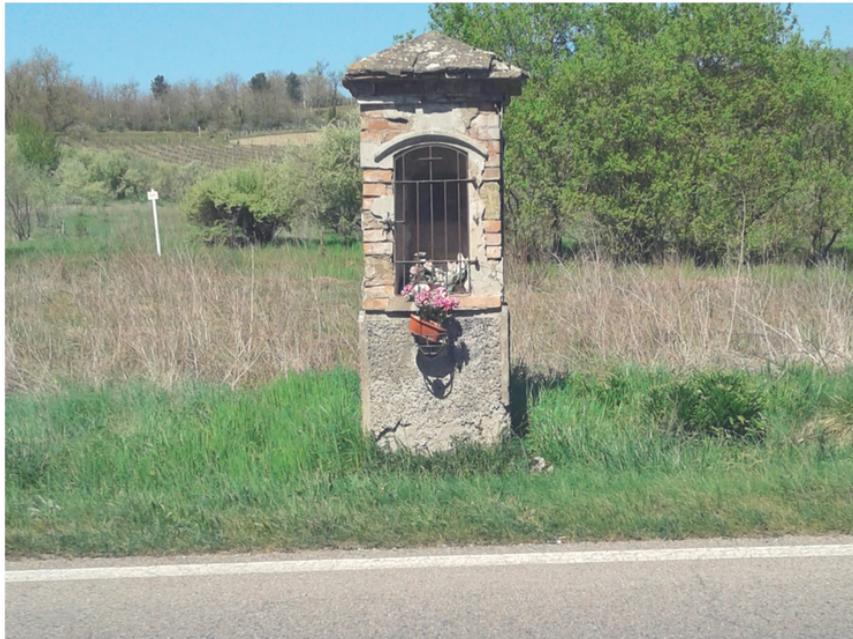
Pietraviva, stradale s.p.540 (direzione Siena)
