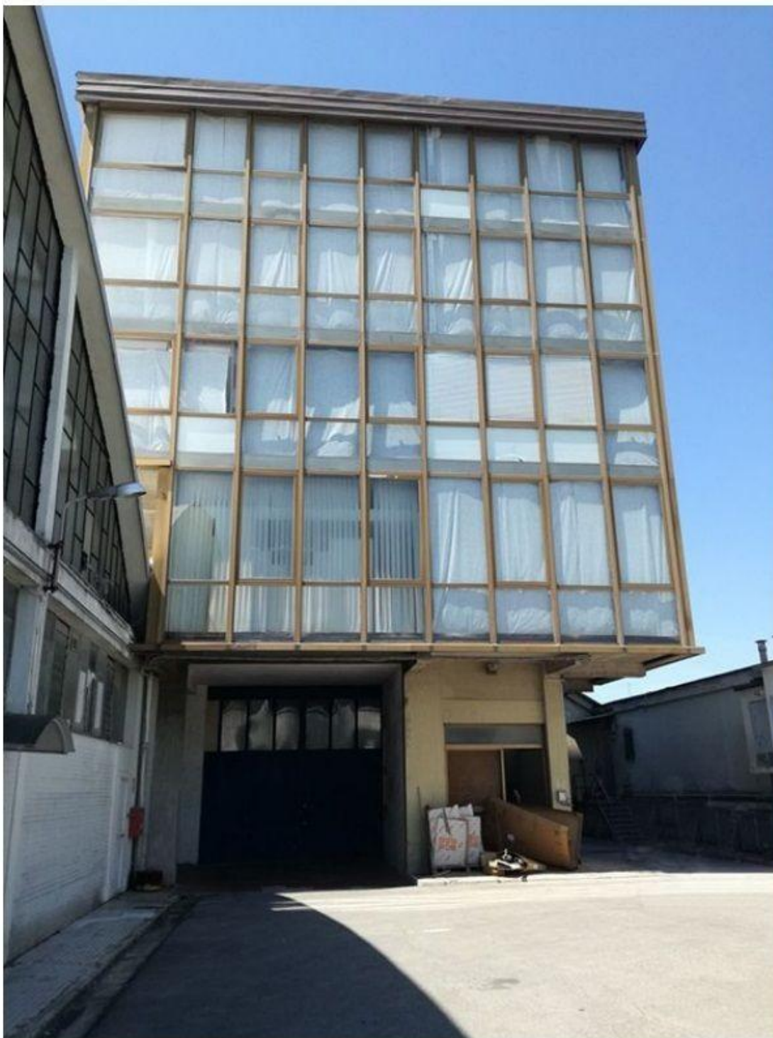
Fig. 1 - Foto dell'ingresso del Grattacielo (prospetto Est) visto dal patio interno.
